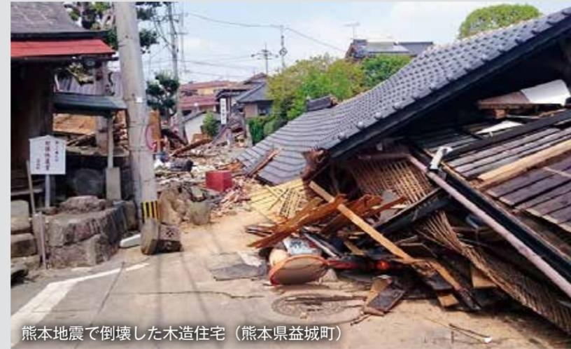
熊本地震で倒壊した木造住宅（熊本県益城町）
